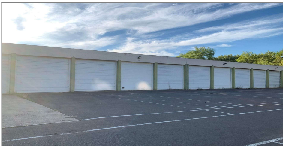
Figure 4 : Vue des garages adossés à l'immeuble principal
